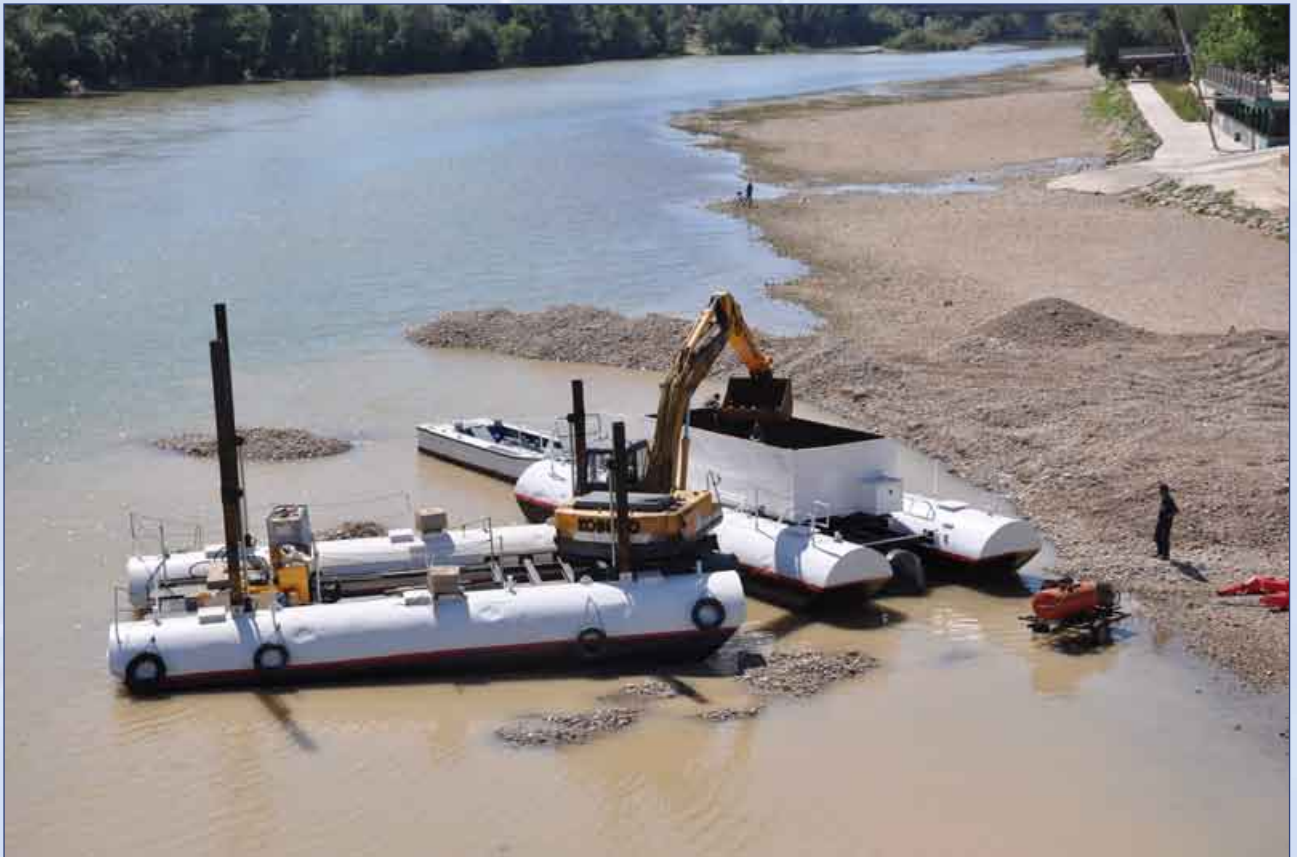
La draga ha extraído en la primera quincena de junio cerca de 2.000 metros cúbicos de gravas.
