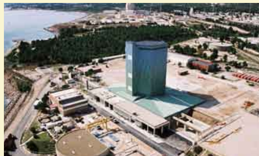
Edificio de contención del reactor de Vandellós I.
