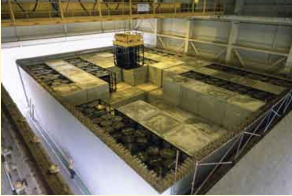
Interior de una celda de almacenamiento (izda.) y trabajos clausura de una celda (dcha.)
