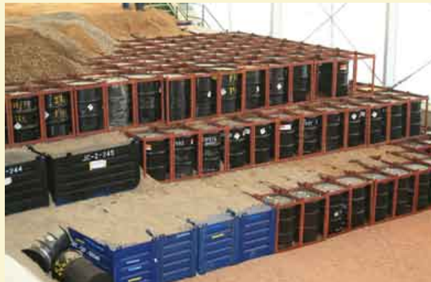
Instalación complementaria para residuos de muy baja actividad.
