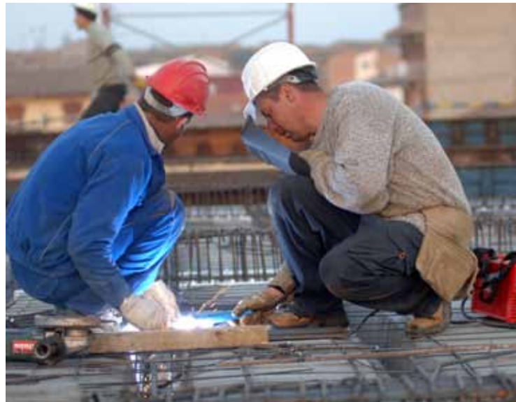
El sector de la construcción ha sido de los más castigados por la crisis.
