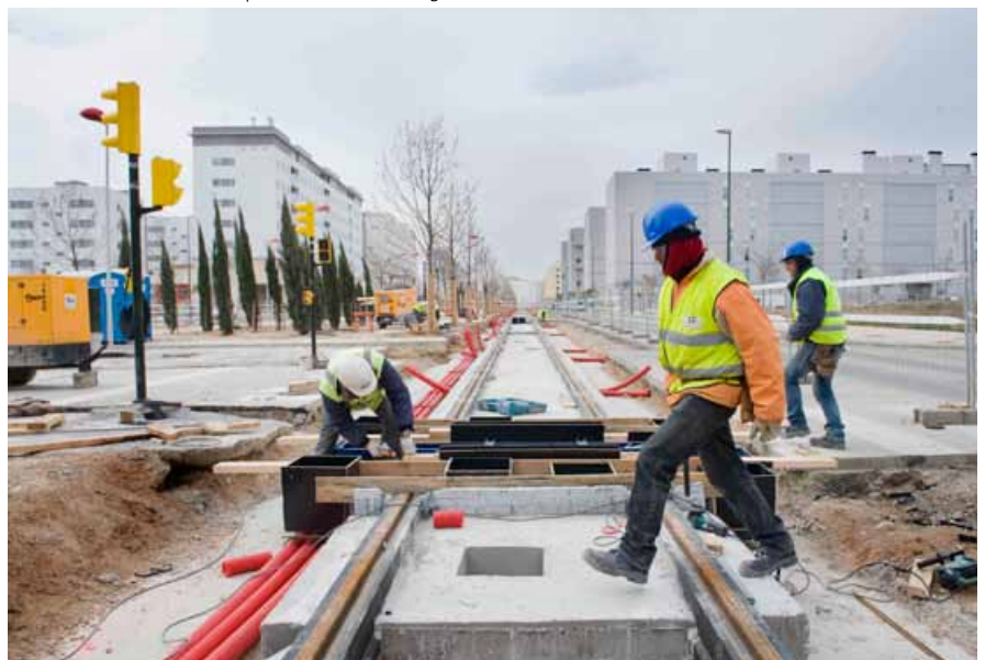
Instalación de servicios auxiliares en la vía, a la altura de Valdespartera.
