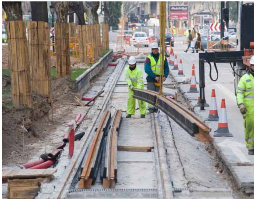
La vía se monta sobre una plataforma de hormigón tras la renovación de las tuberías del subsuelo.
