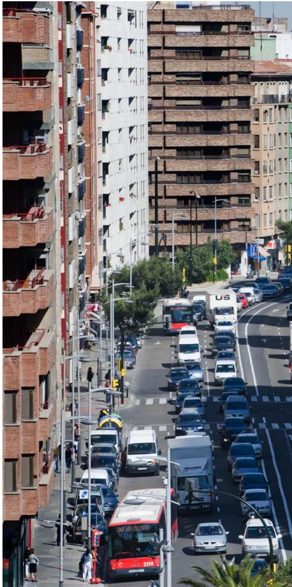
La construcción del andén subterráneo obligará a abrir la avenida de Goya entre Alfárez Provisional y Cortes de Aragón
