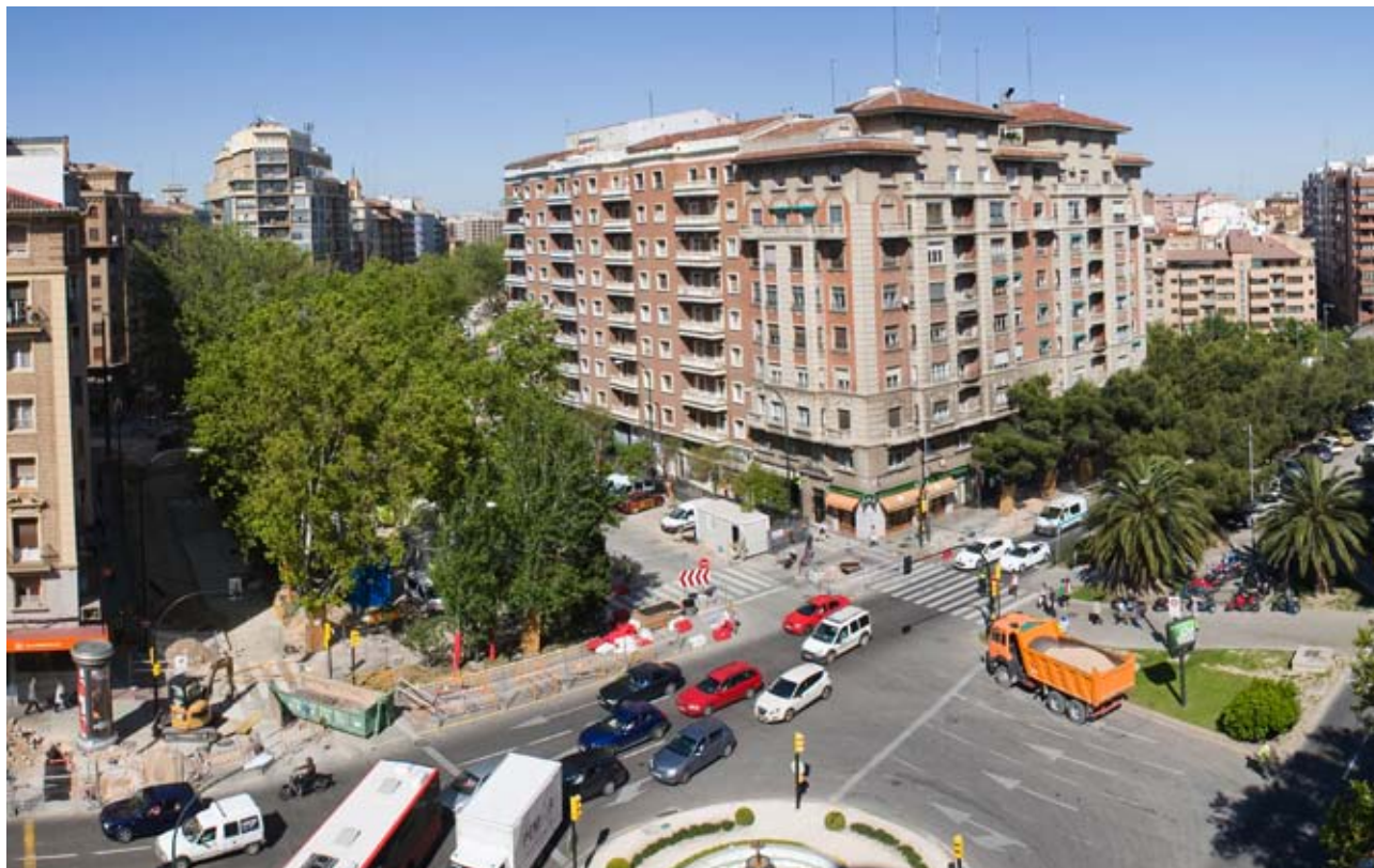
La plataforma tranviaria no se podrá rematar entre Gran Vía y Fernando el Católico hasta que se acabe la obra del apeadero
