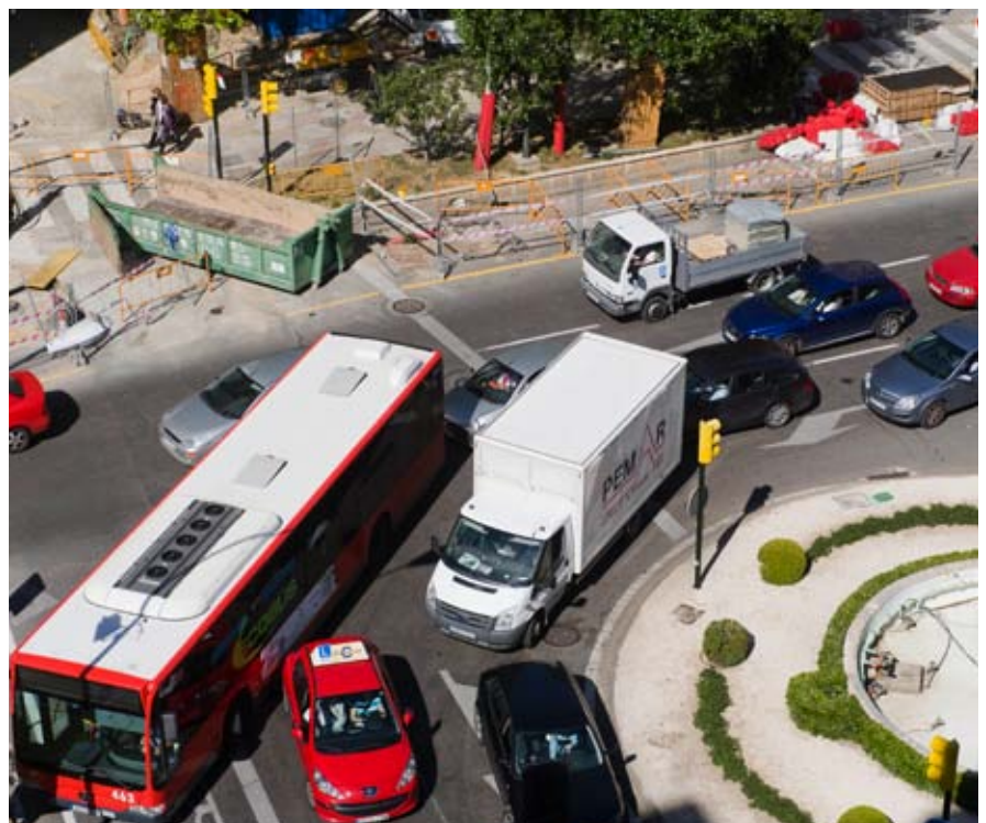
El numeroso tráfico de la zona seguirá siendo uno de los más afectados por las obras.
