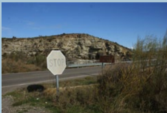
Señalización en mal estado en la A-1209, en Gurrea de Gállego.
