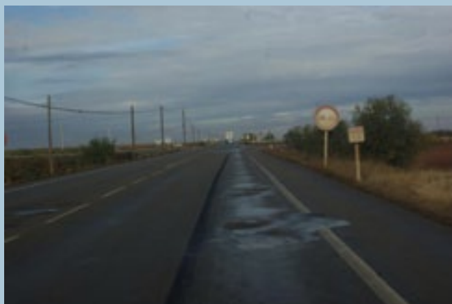
Deformaciones en el firme de la A-220, que une Cariñena con La Almunia.
